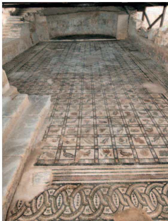
Ο αψιδωτός χώρος Ε. Άποψη από ανατολικά
