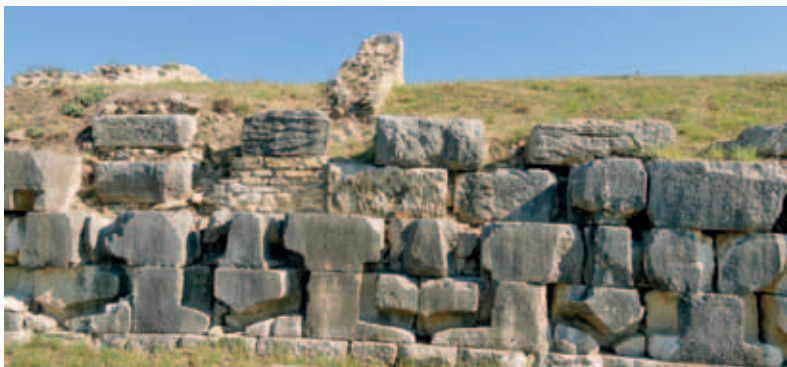
Η πρόσοψη του μνημείου με τα αγκυρόσχημα λαξεύματα για την εισδοχή των ορειχάλκινων εμβόλων
