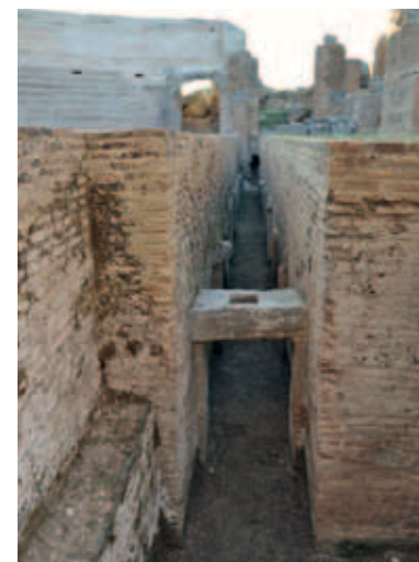
Η αύλακα του μηχανισμού της αυλαίας
