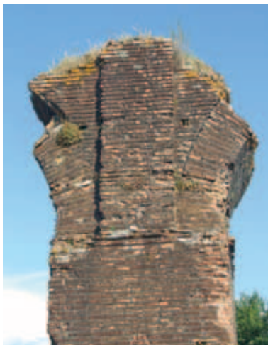
Λεπτομέρεια της τοικοποιίας ενός πεσσού υδραγωγείου
