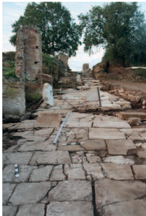
Ο πλακόστρωτος δρόμος δυτικά της Οικίας του εκδίκου Γεωργίου. Αποψη από Β
