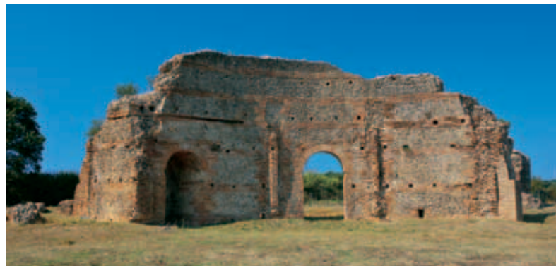
Βόρειες Θέρμες. Άποψη της ημικυκλικής εξέδρας από Α
