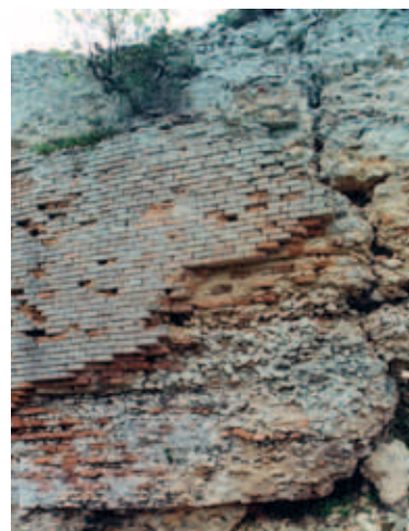
Λεπτομέρεια του βόρειου σκέλους των τειχών: διακρίνεται το λιθόδεμα του πυρήνα
