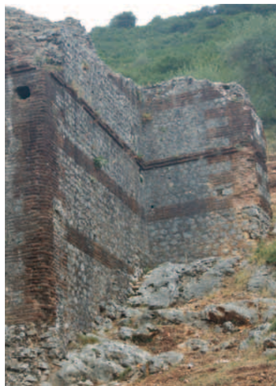
Λεπτομέρεια της βόρειας πεσσοστοιχίας του Υδραγωγείου στον Άγιο Γεώργιο
